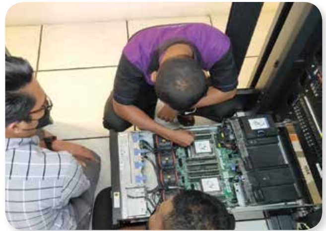
Kerja – Kerja Penyelenggaraan Perkakasan Pusat Data
